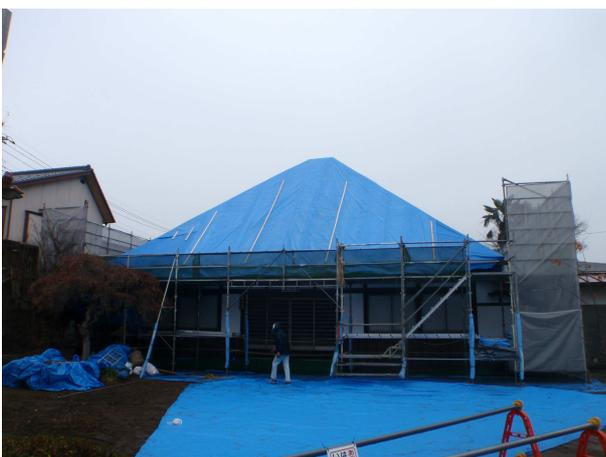
6. ブルーシートによる屋根雨養生状況
