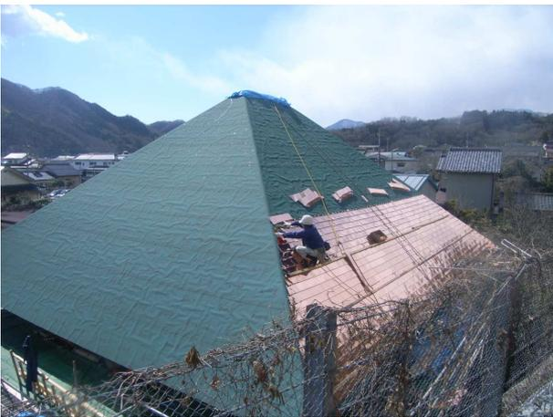
12. 屋根下地防水シート張り・銅板張り施工状況
